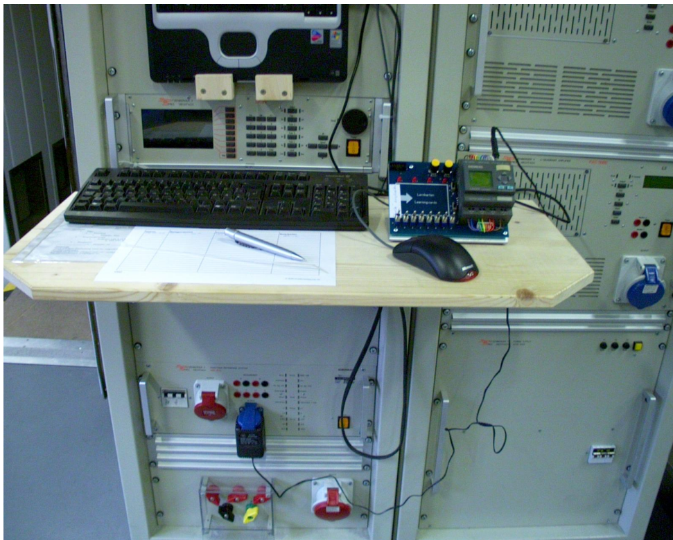
Prüfaufbau Test set-up
